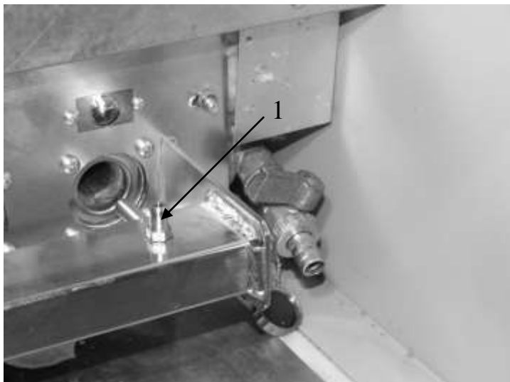
Рис. 7 п.1. Штуцер для замера давления газа в коллекторе горелки
